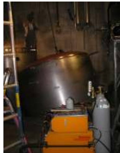
10 Aufbau im speicherraum
