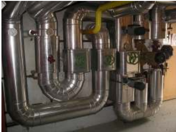
19 Aufwändige Anpassungen in der Zentrale
